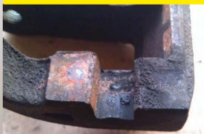
Фото 5. Стан скоби супорта після демонтажу (до очищення!)
